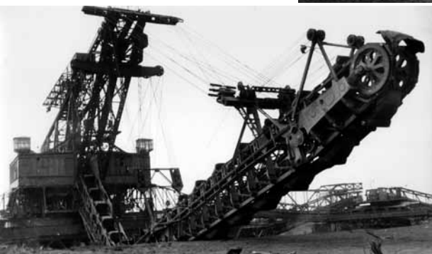
Eimerkettenbagger D650 im Tagebau Niemsch, um 1960
