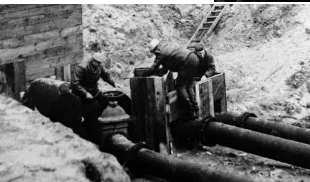
Öffnen der Flutungsleitung für das Restloch Niemtsch, 15. November 1967
