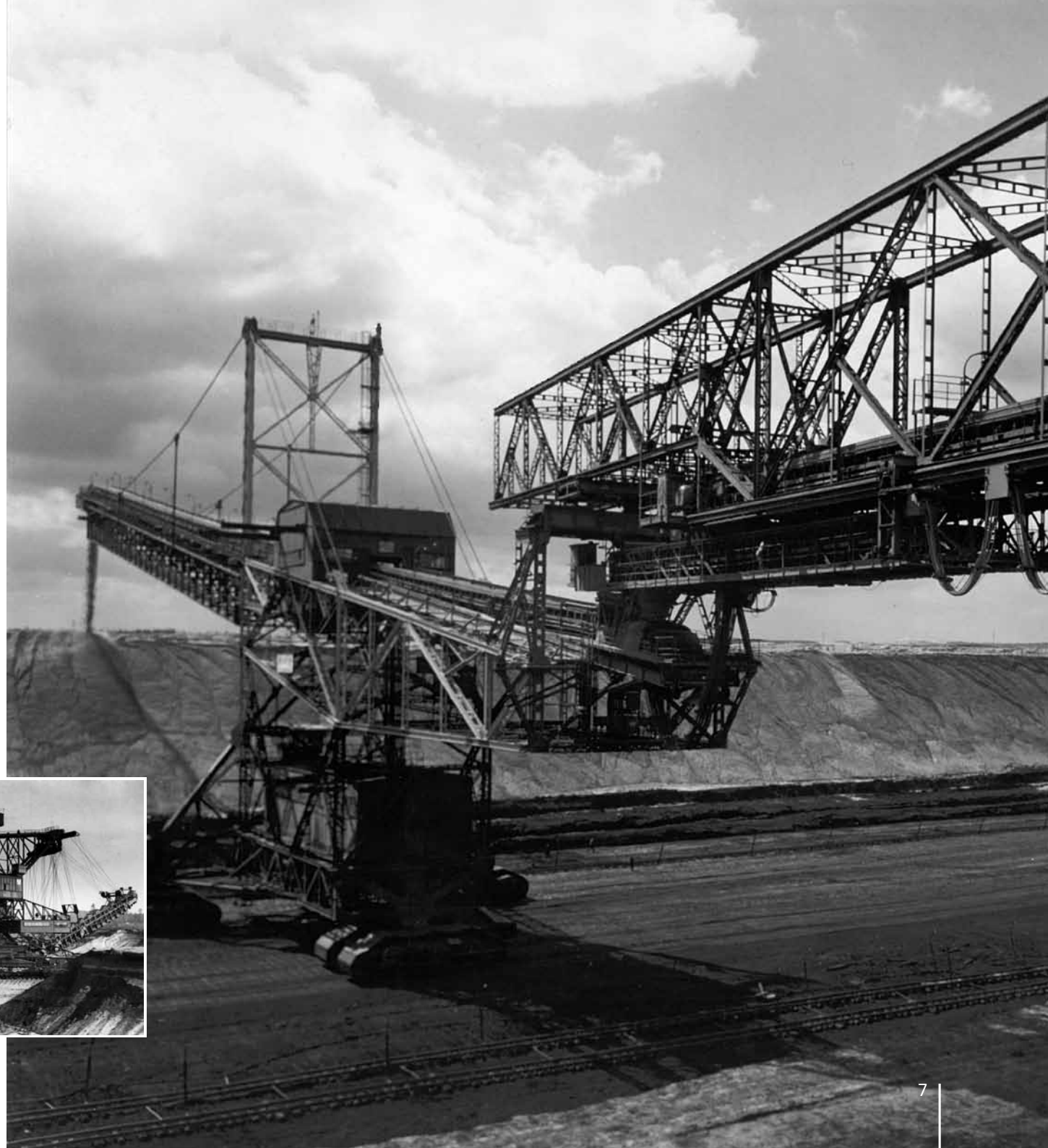
Abraumförderbrücke F25-7 im Tagebau Niemtsch, 1963
