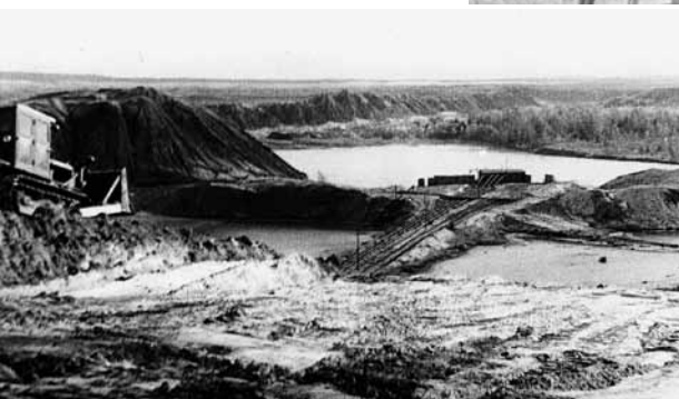
Wasserhaltung im Elsterfeld des stillgelegten Tagebaus Niemtsch, 1966
