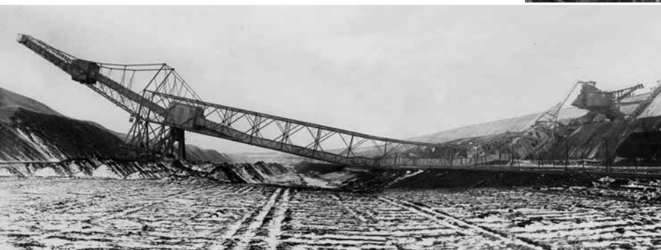
Eingestürzte Abraumförderbrücke im Tagebau Erika, 1937
