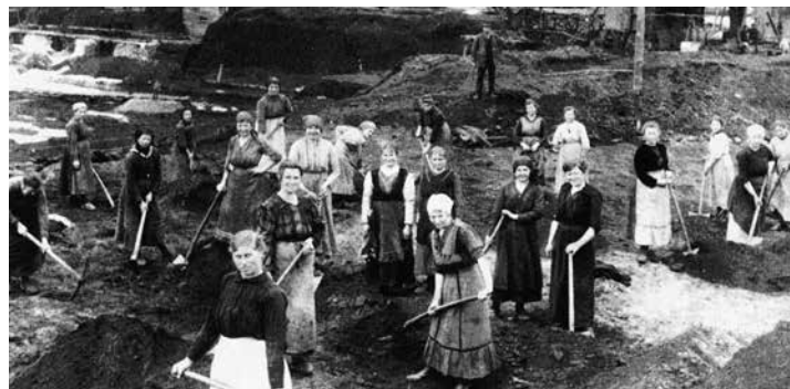
Putzkolonne beim „Nachputzen“ – manuelle Säuberung der Flözoberfläche von Abraumresten, 1925 „Weiße Brücke“ des Braunkohlenwerkes „John Schehr“, 1954
