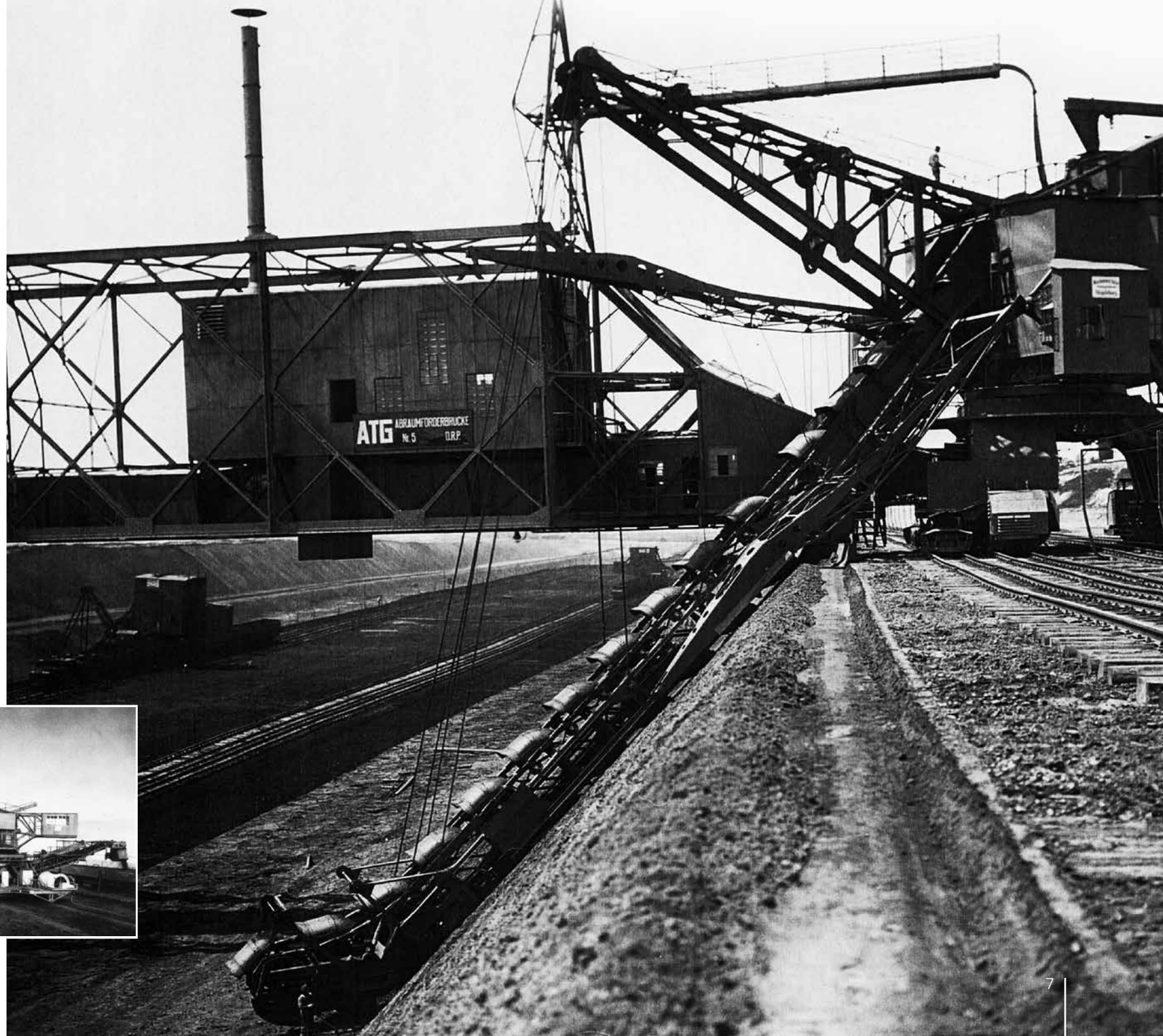
Abraumförderbrücke Erika mit Bagger im Tagebau Laubusch, um 1940
