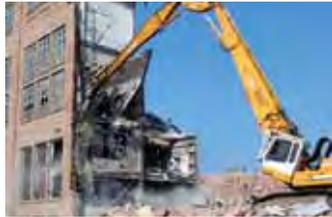
*Abbrucharbeiten an einer Brikettfabrik, 2000*
