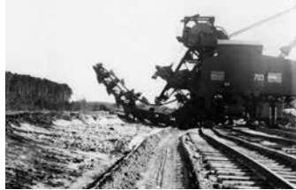
Aufschlussbaggerung im Tagebau Kleinleipisch, 1910
