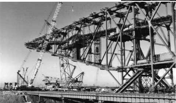
Aufbau der Abraumförderbrücke F60 im Tagebau Klettwitz-Nord, 1990
