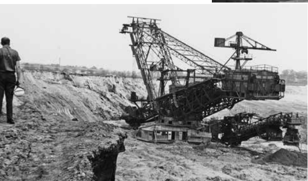
Von Altkippenrutschung eingeschlossener Bagger SRs 1200-131, 1970
